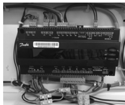
Billede 4: Midlertidig ledningsføring
